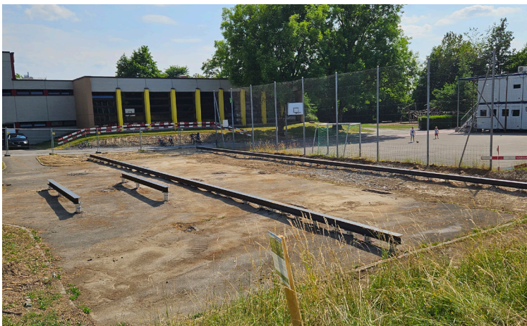
Schraubfundamente und Stahlträger bilden das Fundament der Schule
