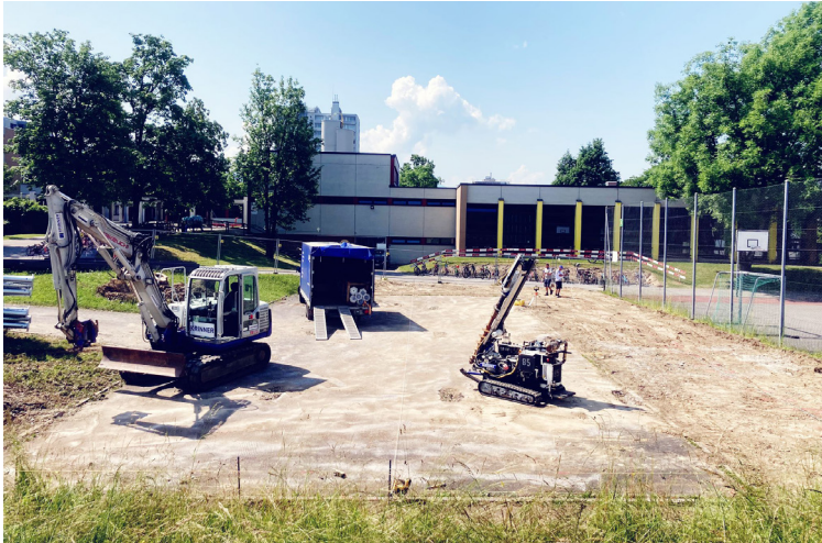
Bauplatz vor Beginn der Montage
