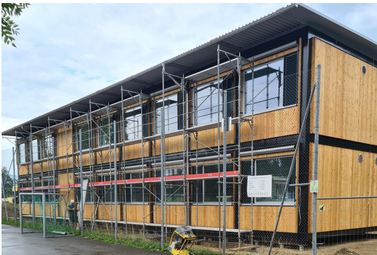
Fertiggestelltes Schulhaus mit einem betonlosem Fundament
