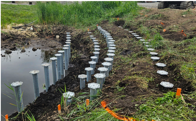
Schraubfundamenten haben minimale Auswirkung auf die Umwelt
