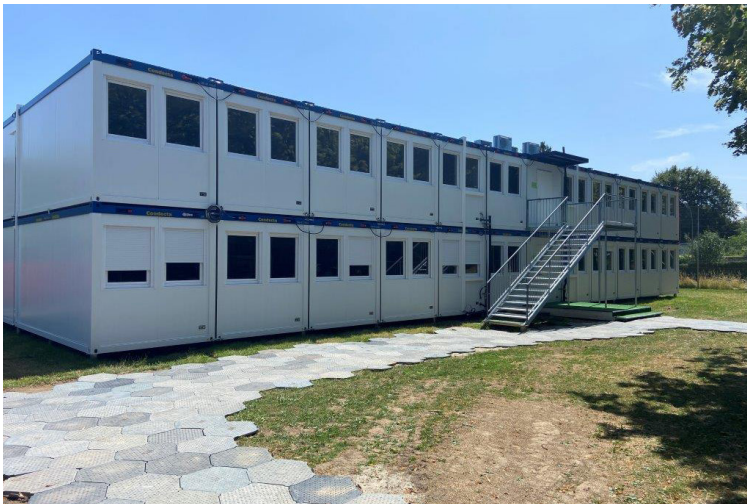
Schulprovisorium auf Krinner Schraubfundamenten
