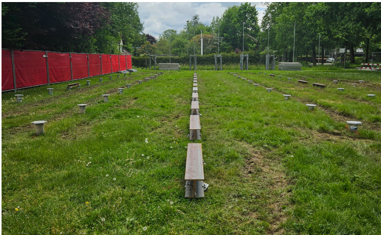
Stahlträger und Schraubfundamente bilden ein stabiles Fundament
