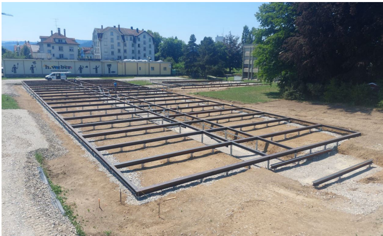
Insgesamt wurden 344 Schraubfundamente verbaut
