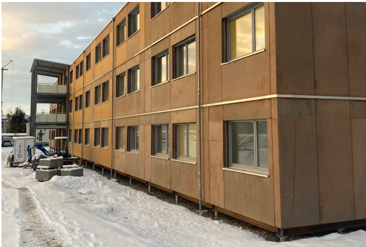
Fertiges Wohnheim auf betonlosem Fundament
