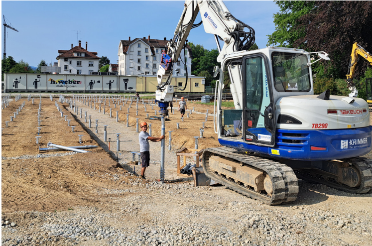
Eindrehen der Schraubfundamente mit 8 Tonnen Baggern
