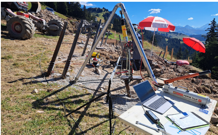
Belastungstests (Zug) zur Charakterisierung des Lastabtrages
