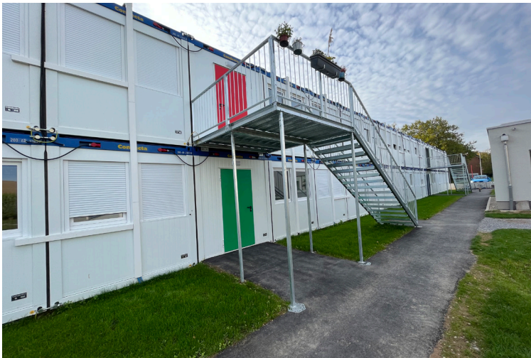
Fertiggestellte Asylunterkunft auf betonlosem Fundament
