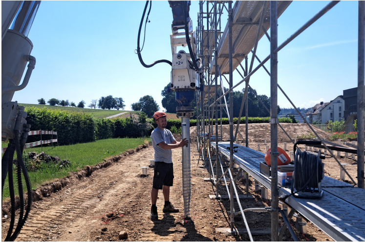
Einbau der Schraubfundamente mit Bagger-Anbaugerät KRB 250
