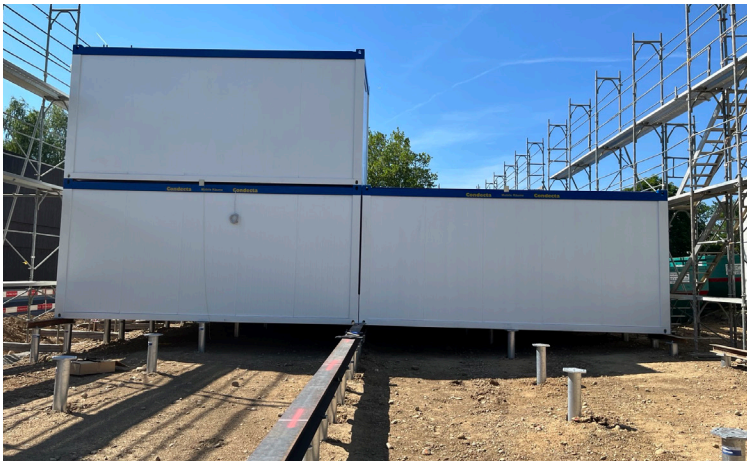
Krinner Schraubfundamente sind direkt nach der Montage belastbar
