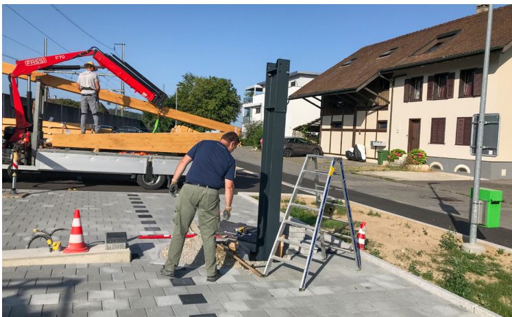
Stahlträger und Schrauben bilden unter den Steinplatten ein stabiles Fundament
