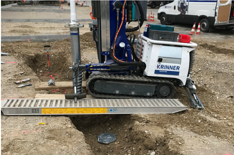
Einbau der Schraubfundamente mit dem Raupenfahrzeug KR D 30
