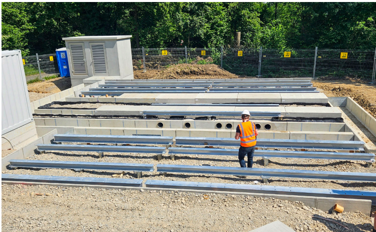
Die verzinkten Stahlträger werden auf den Schraubfundamenten fixiert
