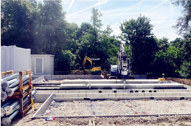
Die Schrauben werden präzise mit dem Bagger-Anbaugerät KRB 250 eingedreht
