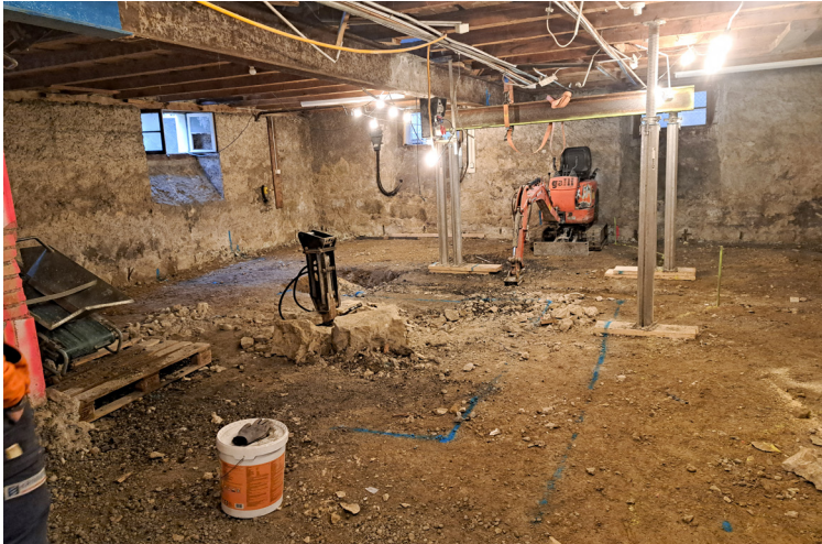
Keller des vierstöckigen Gebäudes vor Aushub
