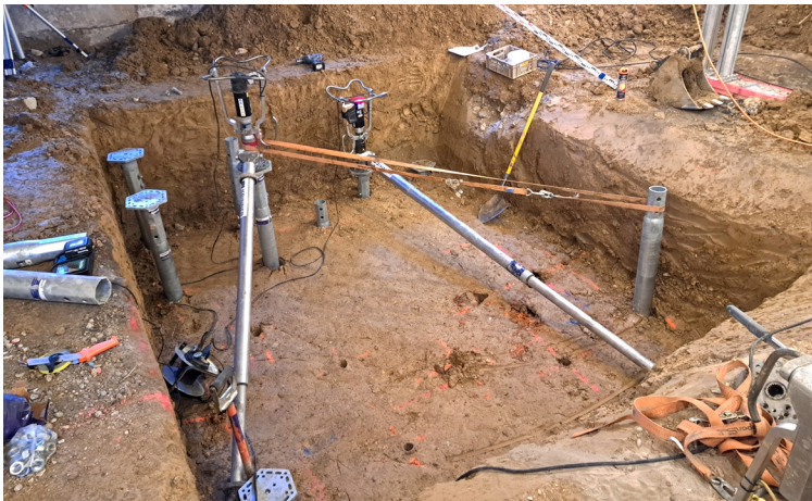
Die Schraubfundamente wurden millimetergenau platziert
