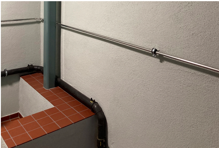
Fertige Kellerabstützung innerhalb von 9 Stunden fundiert
