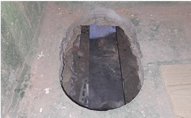
HEB Stahlträger fest auf Schraubfundamenten montiert
