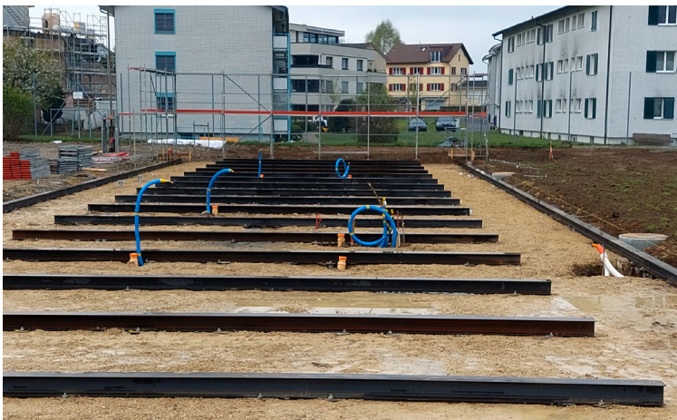
Die 266m Stahlträger bilden die Gebäudeplattform
