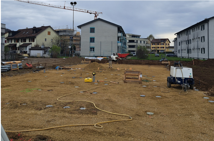
Nach den Vorbohrungen konnten die Schraubfundamente platziert werden
