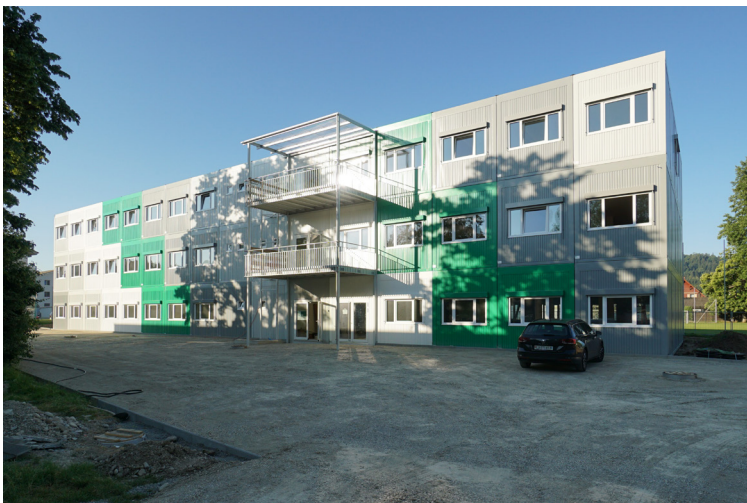
3-geschossiger Schulraum als temporäre Lösung
