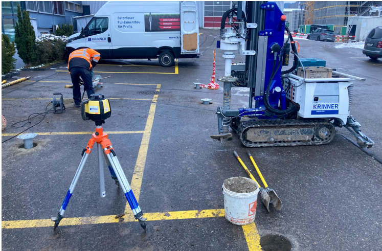
Nach der Kernbohrung wurden die Schraubfundamente gesetzt
