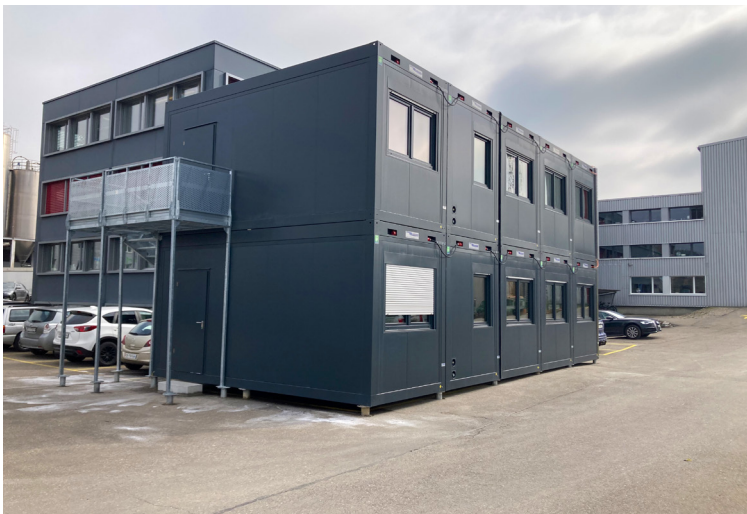
Dank des schnellen Einbaus konnten die Bürocontainer sofort genutzt werden
