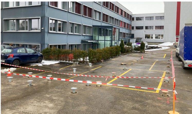
Die Schrauben sind trotz unebenem Baugrund auf gleicher Höhe ausnivelliert
