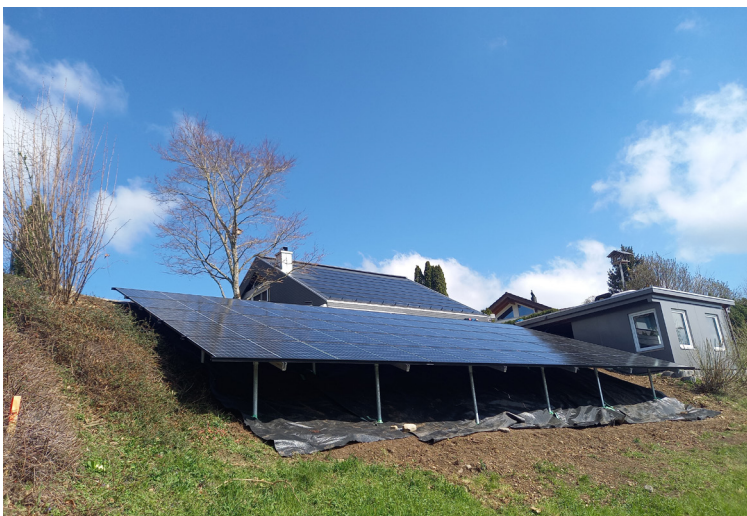
Fertige Anlage mit Vegetationsschutz
