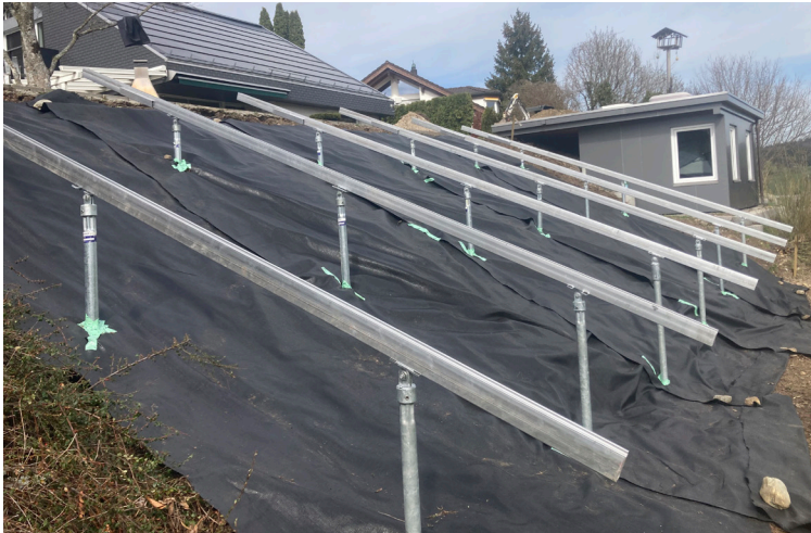
Unterkonstruktion Sparren auf drei KSF S-Fundamenten
