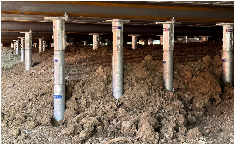
Durch Stahlträger gebildete Gebäudeplattform
