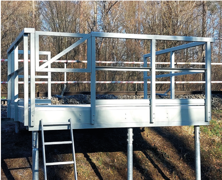
Der Hangausgleich wurde durch die Schraubfundamente von Krinner hergestellt
