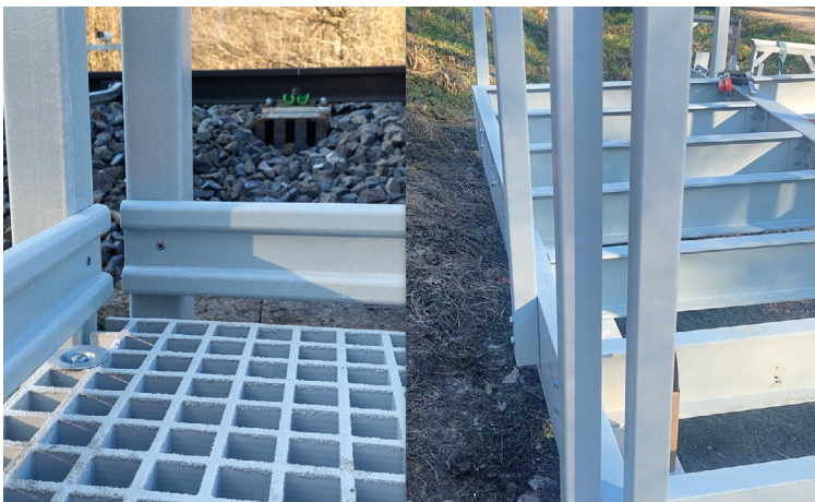
Der nicht leitende GFK-Kunststoff eignet sich optimal für diese Art von Anwendung
