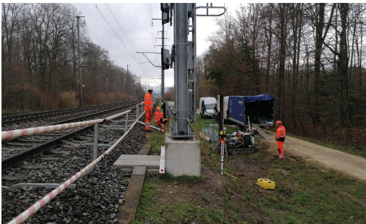
Mit der elektrischen Eindrehmaschine können Schraubfundamente auch an Hanglagen montiert werden
