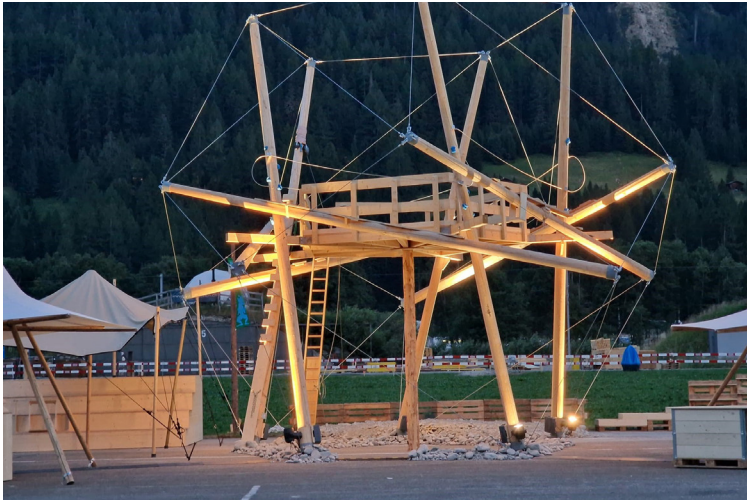
Fundamentbau im Asphalt
