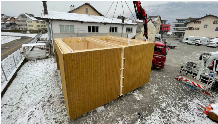
Direkte Montage der Holzmodule auf die Schraubfundamente
