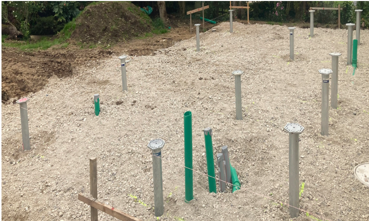
Einbau der Schraubfundamente erfolgte ohne grossen Aushub in Kiesbelag
