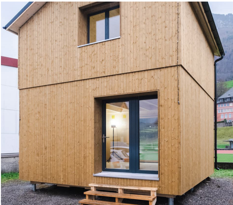
Fertiggestelltes Haus auf Schraubfundamenten
