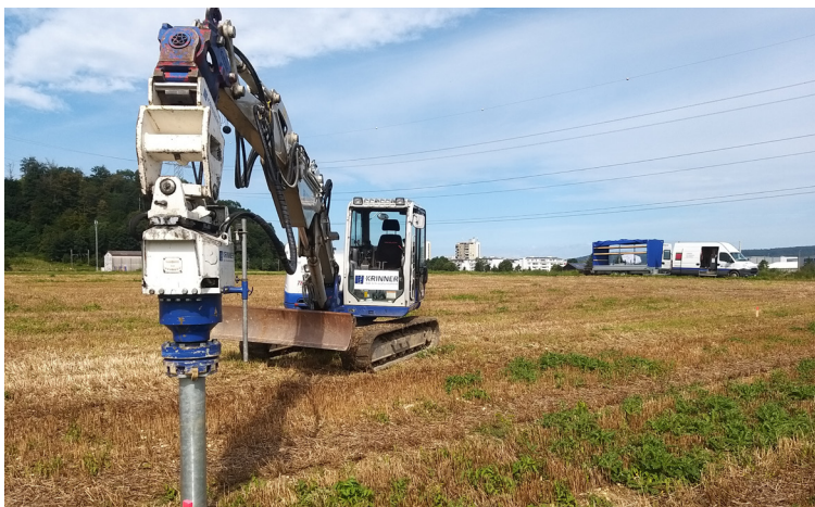
Einbau mit 8t-Bagger und Spezialanbaugerät KRB 250
