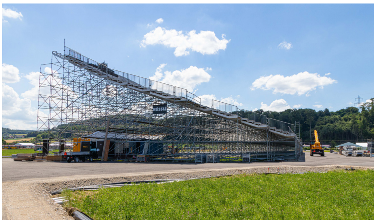
Insgesamt wurden 224 Schraubfundamente zur Verankerung der Dachabspannungen der Schwingarena installiert
