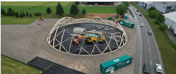
betonlose fundierte Holz-Rundkuppel
