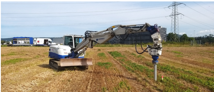
Vorversuche / Baugrundabklärung zur Dimensionierung
