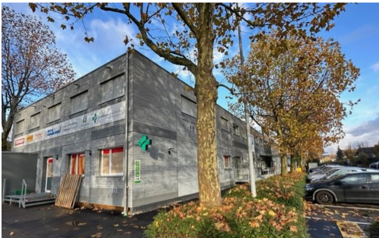
2-geschossiger Holzmodulbau auf Schraubfundamenten
