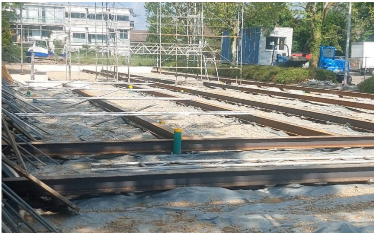
Die Schraubfundamente und Stahlträger wurden von Krinner geliefert und installiert
