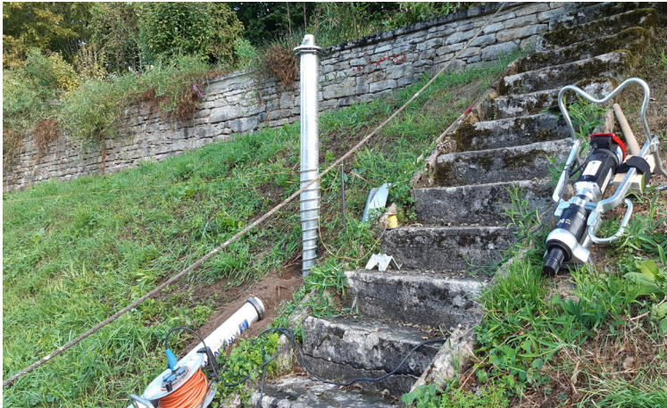
Schraubfundamente sind dank leichtem Montagematerial für Hanglagen geeignet
