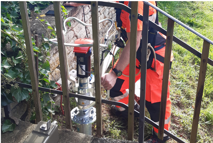
Einbau eines Schraubfundamentes
