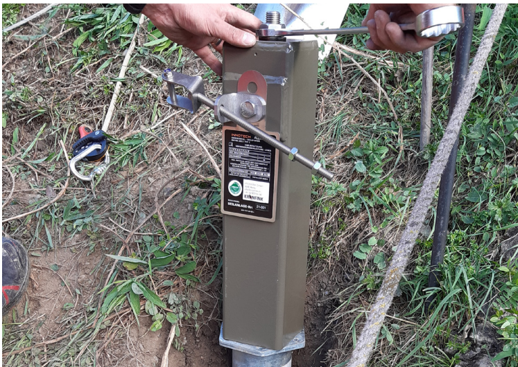
Der Anhängepunkt wird mit dem Flansch des Schraubfundamentes verbunden
