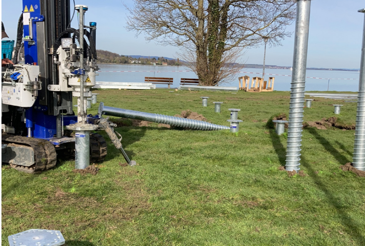
Einbau der Schraubfundamente mit Raupenfahrzeug KRD 30
