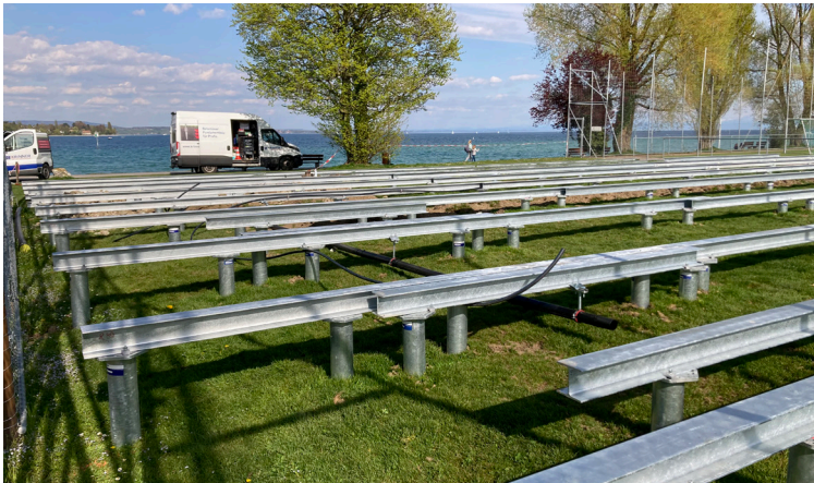
Montage der verzinkten Stahlträger auf den Schraubfundamenten
