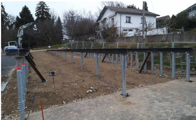
Hangausgleich mit Schraubfundamenten hergestellt
