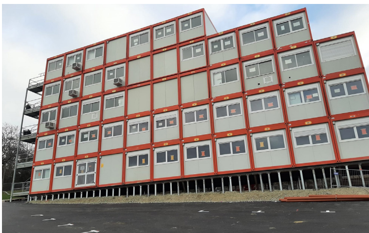
Fünfstöckige Containeranlage auf Schraubfundamenten
