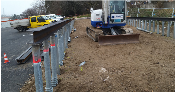
Die verlängerbaren Schraubfundamente eignen sich optimal für schwere Lasten
