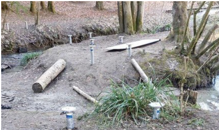
Einbau von 115 Krinner Schraubfundamenten in Waldboden
