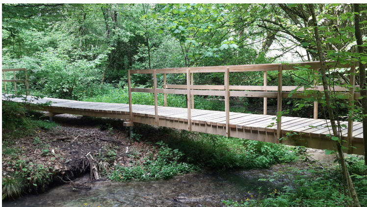
Terrainunterschiede lassen sich mit Schraubfundamenten problemlos bewältigen
