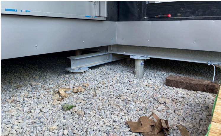
Module können sofort nach dem Einbau der Schraubfundamente platziert werden.
