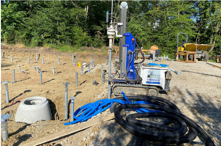
Eindrehen der Schraubfundamente mit Raupendumper KRD 30
