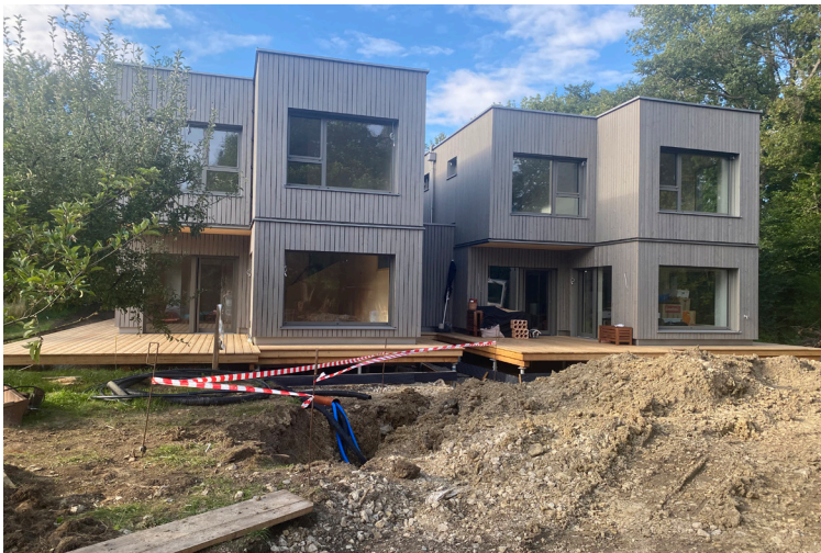
Modulhaus auf Krinner Schraubfundamenten
