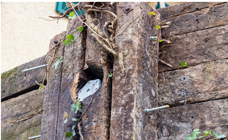
Hangsicherung in Wohnquartier
